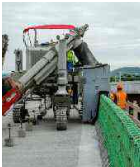
Pouring barrier over rebar cage.
